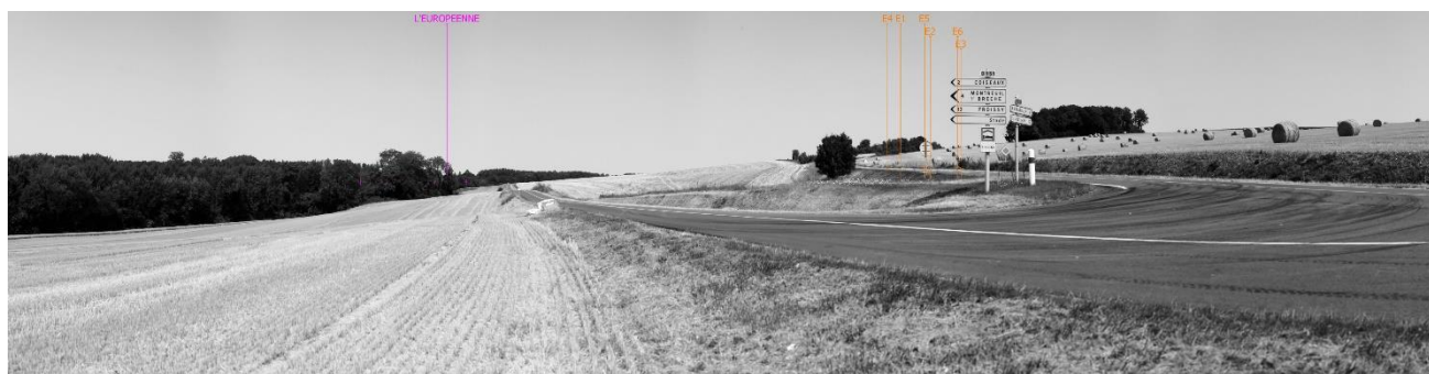
Figure 9 : Photomontage au niveau du croisement D151/D938, au niveau de la vallée de la Brèche
